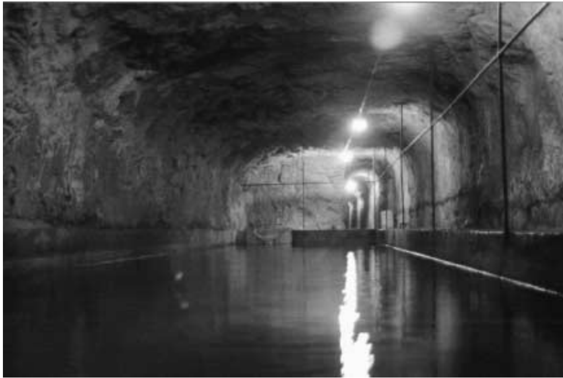
Vasca di raccolta di un acquedotto
