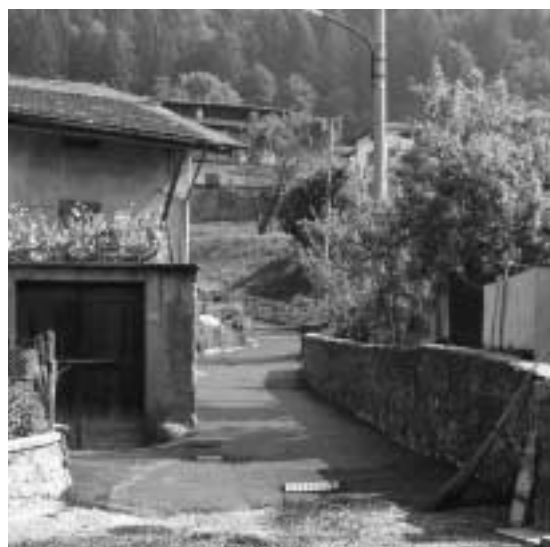
La viabilità del centro di Vigolo Vattaro oggetto dei lavori
