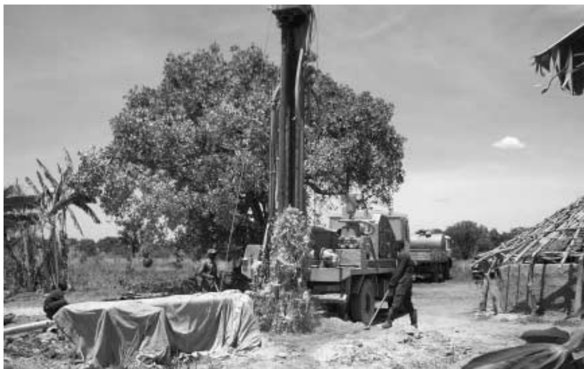
Lo scavo di un pozzo d'acqua
