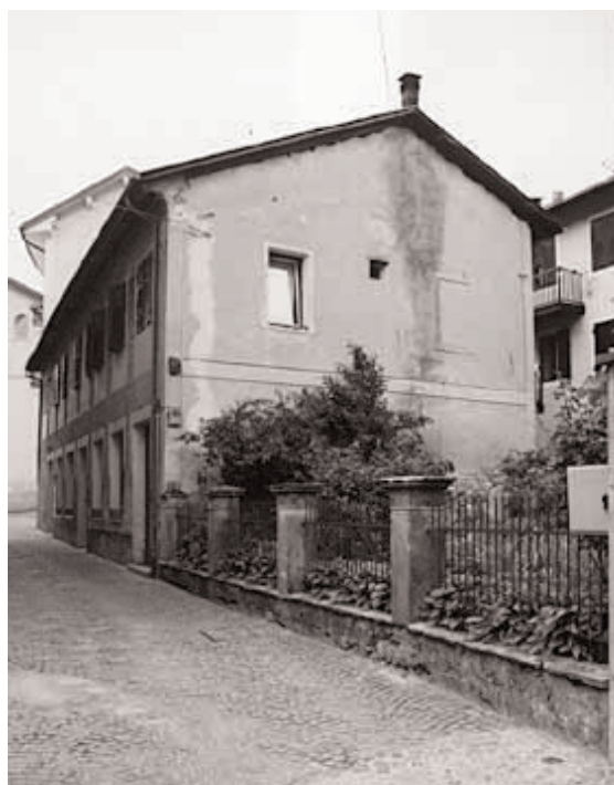
Strigno - edificio di Via Pretorio
