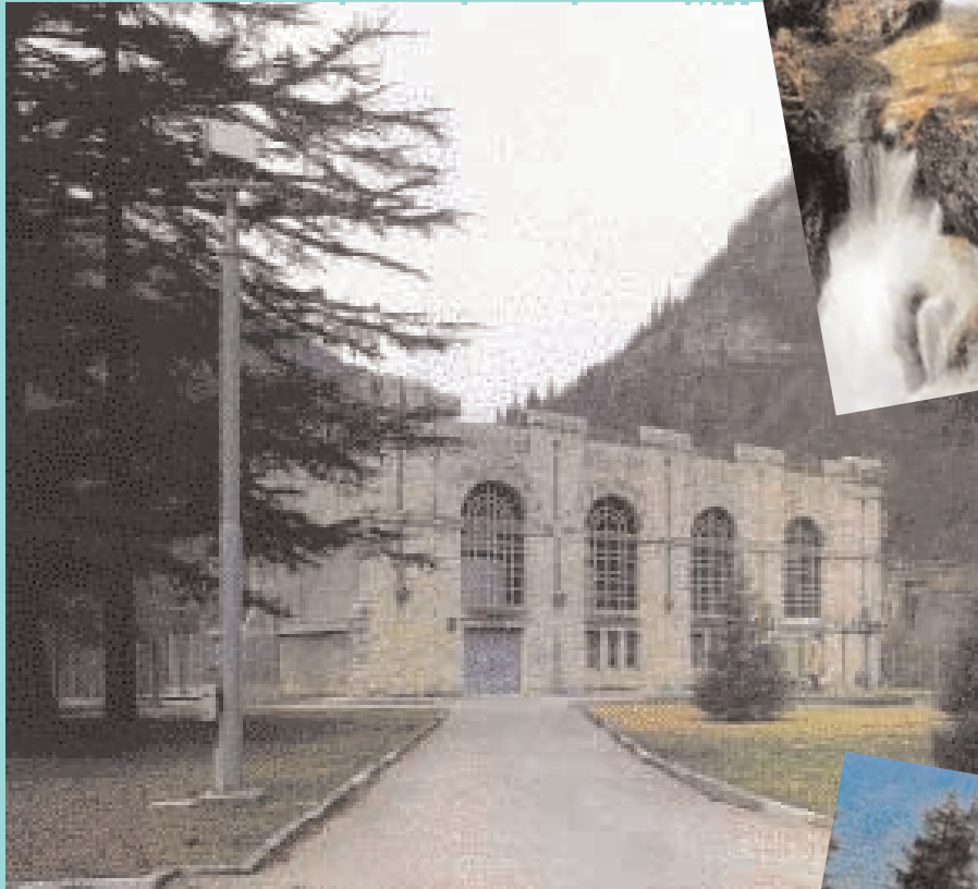
La centrale di Pedesalto
