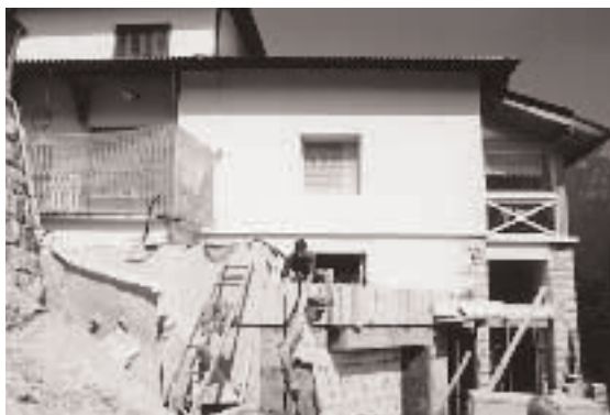
Realizzazione sala polivalente nella frazione di Ronco Chiesa
