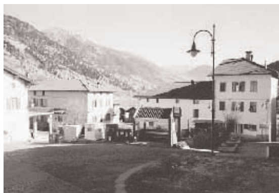
Torcegno, nuova illuminazione
